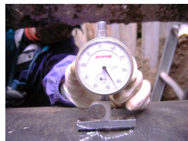
管外面の腐食深さを計測
