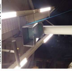
電波吸収シート取付状態
