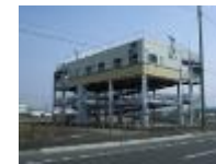
津波避難タワー
