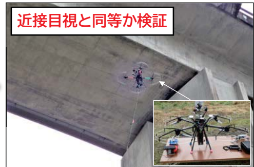
橋梁点検支援技術による点検
