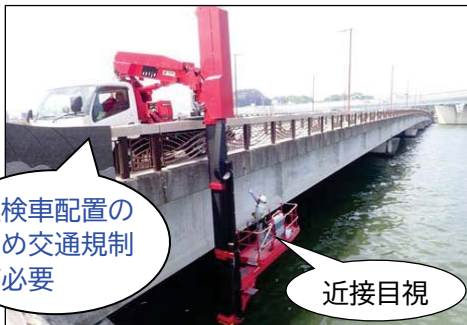
近接目視点検
