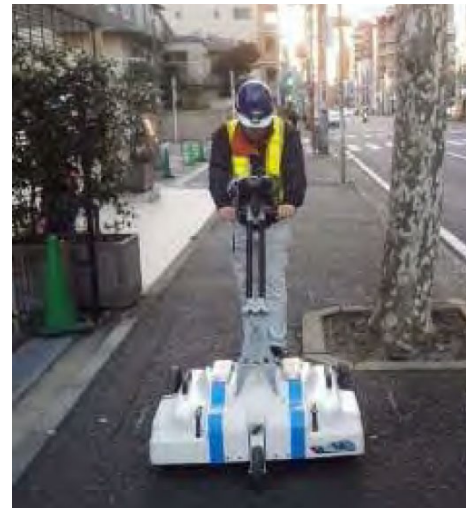
地中レーダを活用した調査(機械)
