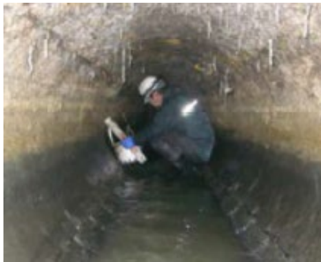
現状の管渠断面調査
