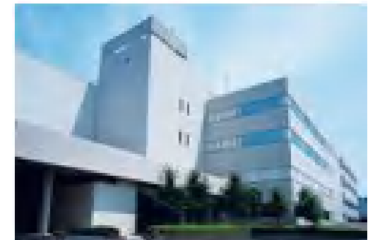
【湘南データセンター】
