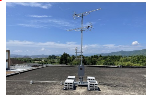
地デジ水蒸気量観測装置 (薩摩川内市)
