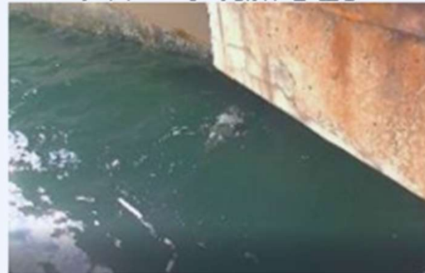
水中構造物の錆、ひび割れの調査
