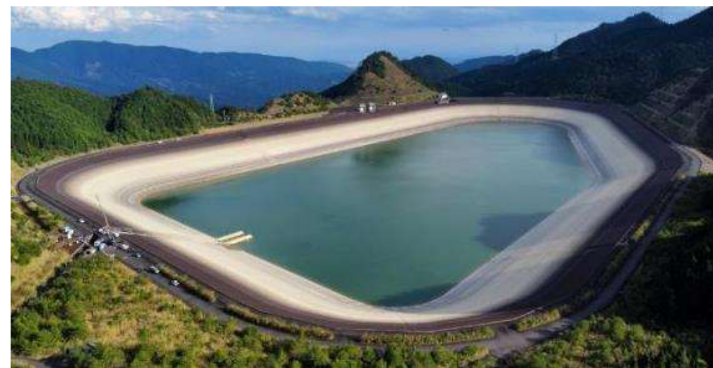
大瀬内ダム全景
