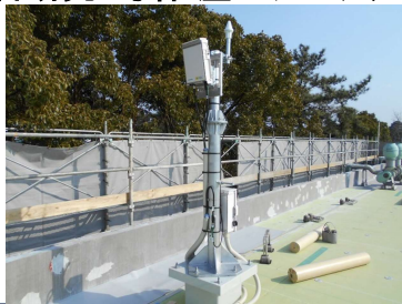
総合研究3号棟 屋上アンテナ
