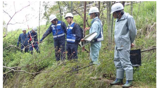
▲ 被災現場で法面の復旧工法を技術的に検討
