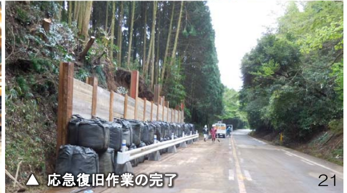
▲ TEC-FORCEが被災状況を調査後、土砂撤去
