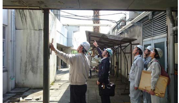
▲ TEC-FORCEと日建連、県建設業協会が共同で調査
