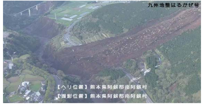
▲ 土石流による道路寸断、橋梁の喪失
