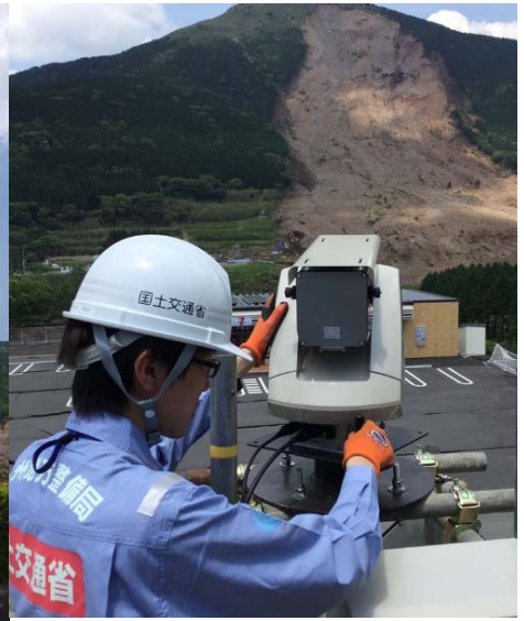
監視カメラ設置状況 (R57阿蘇大橋被災現場)
