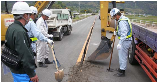
▲ 熊本河川国道事務所による道路復旧の工事監督支援
