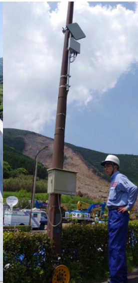
i-RAS設置状況 (R57阿蘇大橋被災現場)
