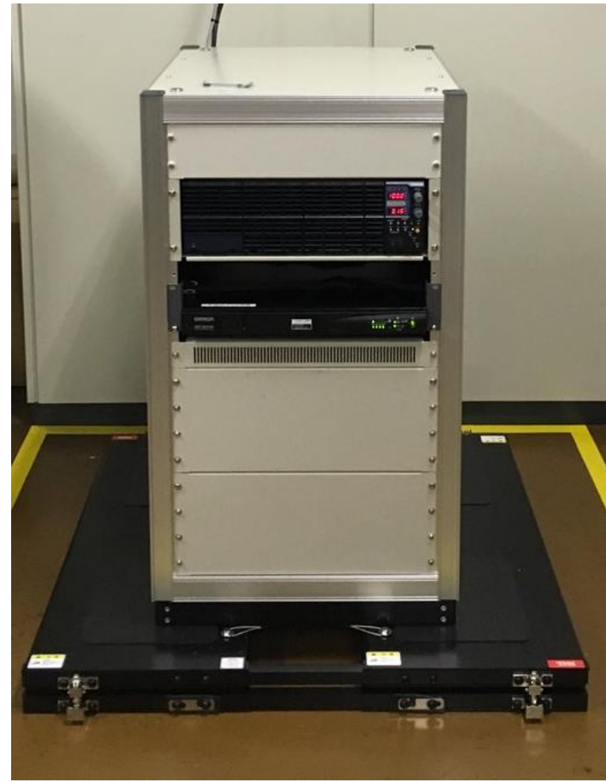
免震ラックに電源設備を実装
