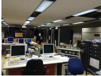
仮復旧した マシン室
