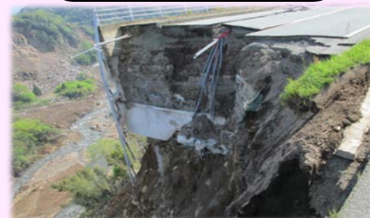
立野地区での道路崩壊、地下管路損傷
