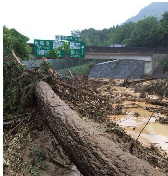
土砂が流入した 山陽自動車道
