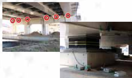
(橋梁の劣化監視)
