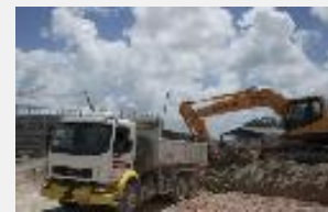
ゼネコンが建設現場で導入 建機遠隔制御
